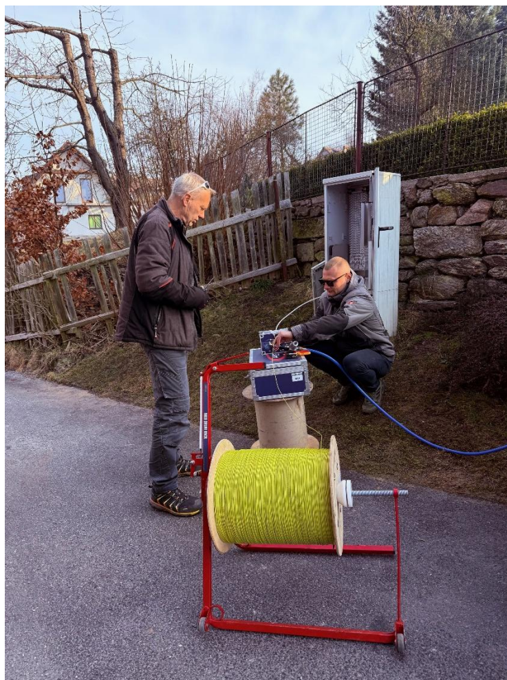
Zafukování optických kabelů ve Sněžném
