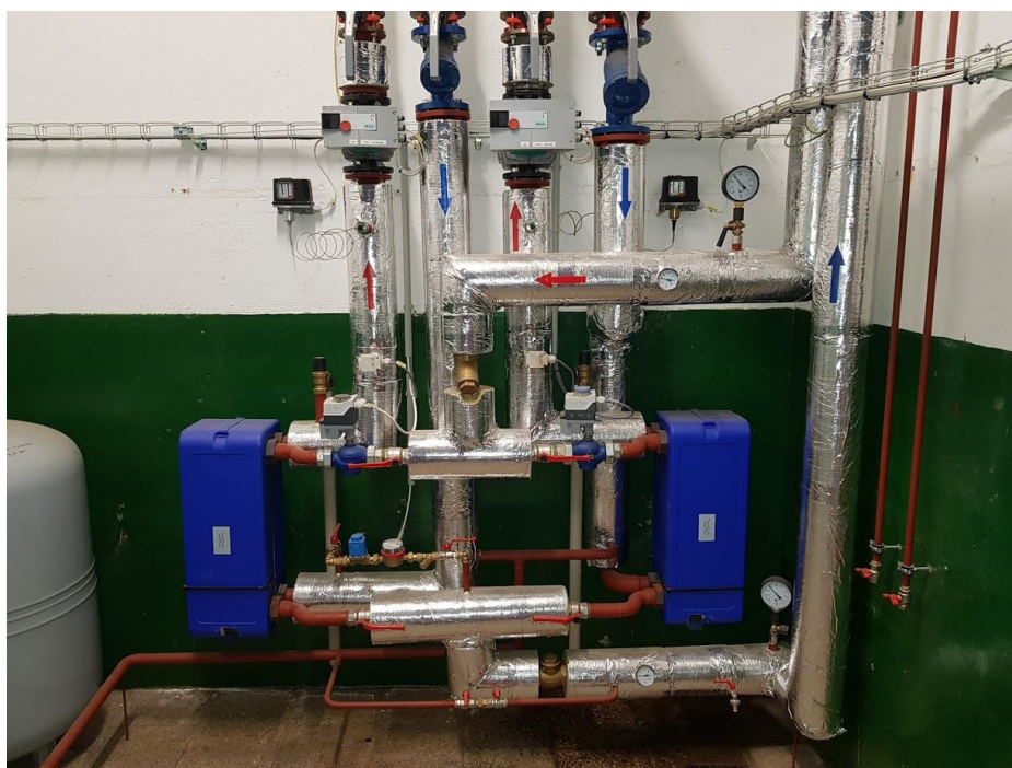
Obrázek 5 Moderní objektová předávací stanice
