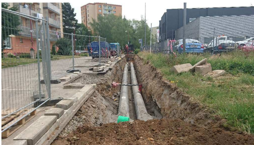
Obrázek 1 Rekonstrukce horkovodu v úseku Auto ... - Global elektro, Žďár nad Sázavou
