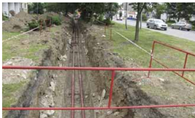
Rekonstrukce horkovodu VS 3 Libušín.
