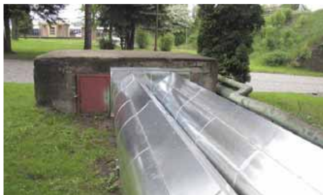
Oprava izolací horkovodu.
