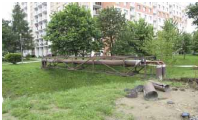
Oprava izolací horkovodu VS 3 Libušín.
