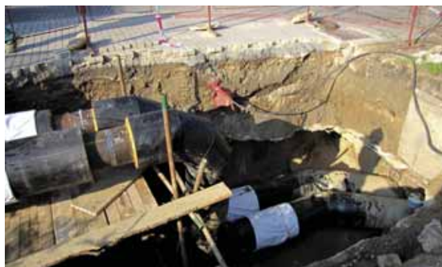
Oprava horkovodu na ul. 1 Máje ve Žďáře nad Sázavou.
