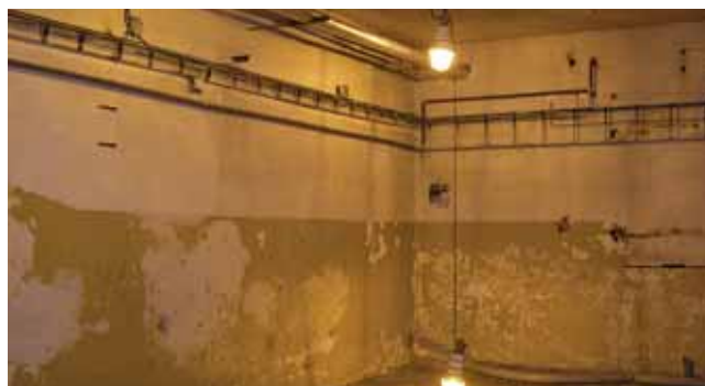
Prostory VS 23 před přestavbou (serverovna).
