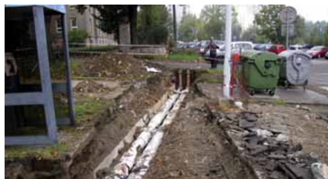
Odstraňování horkovodu před rekonstrukcí na ul. Palachova ve Žďáře nad Sázavou.
