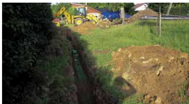
Rekonstrukce horkovodu v lokalitě Dagmarky ve Žďáře nad Sázavou.
