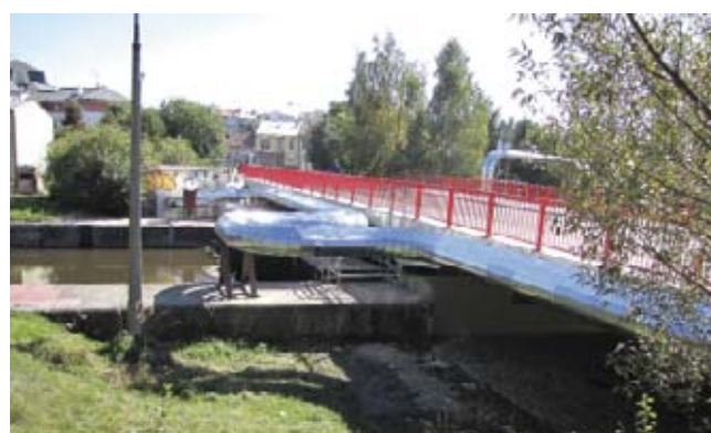
Rozvody po provedené opravě izolací.
