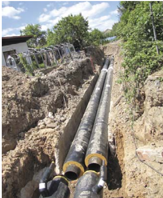
Rekonstrukce horkovodu v lokalitě Dagmarky ve Žďáře nad Sázavou.
