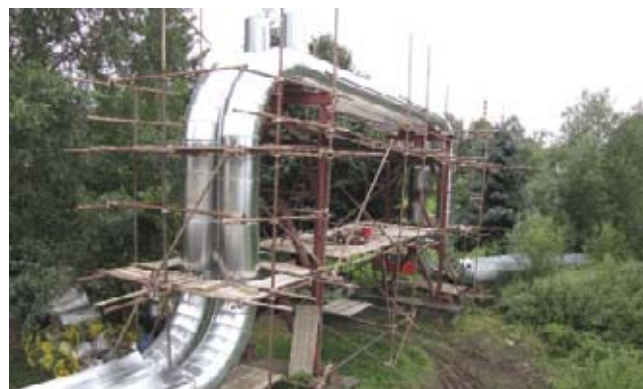
Realizace opravy izolací rozvodů.
