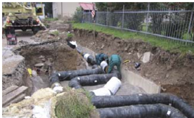
Oprava horkovodu na ul. Komenského ve Žďáře nad Sázavou.
