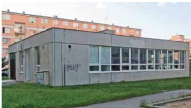
Budova bývalé výměňkové stanice na ulici Libušínská ve Žďáře nad Sázavou po výměně oken, dveří a vrat.
